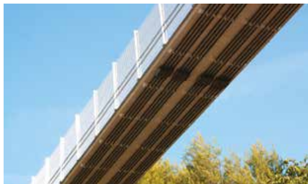
Pasarela peatonal sobre el río Júcar a su paso por Cuenca
