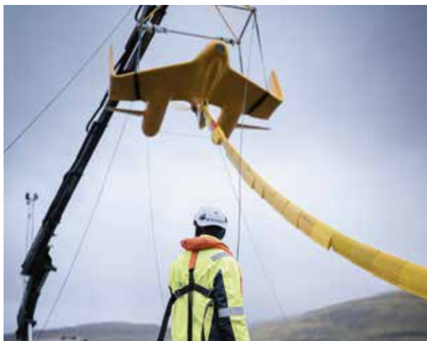
Conjunto del sumergible Minesto Dragon 4 y su amarre listo para su instalación
