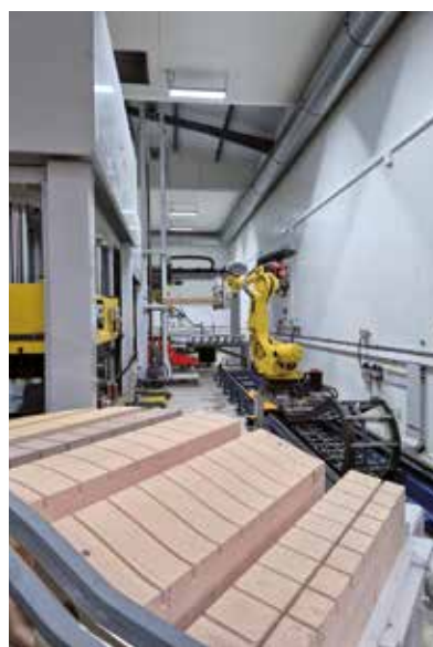
Línea automatizada de preformado para la fabricación de hojas de composite, instalada en Ziur Composites
